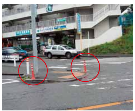
山崎団地の交差点に設置された安全ポール
