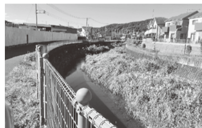
トイレ設置が求められる鶴見川遊歩道
