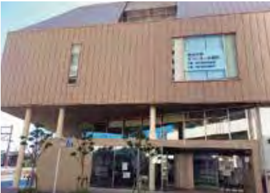
鶴川駅前図書館が入っているポブリホール
